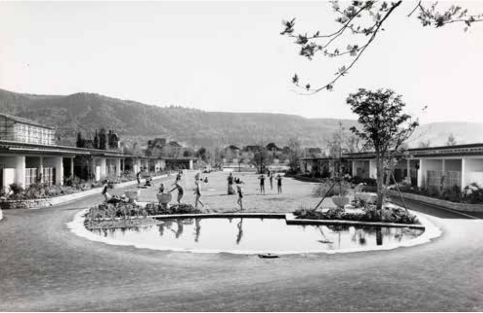
78 Straße und Bad Letziggraben im Bau 79 Eingangsbereich kurz nach der Eröffnung 1949: Das Wasserbecken nimmt die Besucher in Empfang und leitet sie zu den ursprünglich nach Geschlechtern getrennten Sammelgarderoben; im Hintergrund das große Schwimmbecken.
