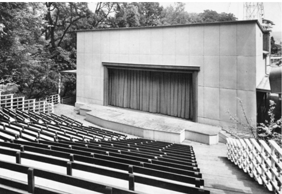
107 Freilichtbühne des Landi-Theaters von Charles Thévenaz
