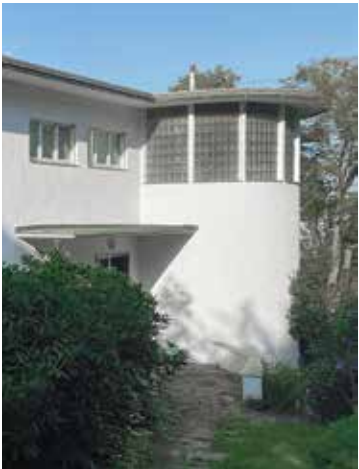
62 A. H. Steiner: Wohnhaus R. Hauser-Studer, Zürich (1937–1938); Eingangspartie mit glasbausteinbesetztem Treppenturm
