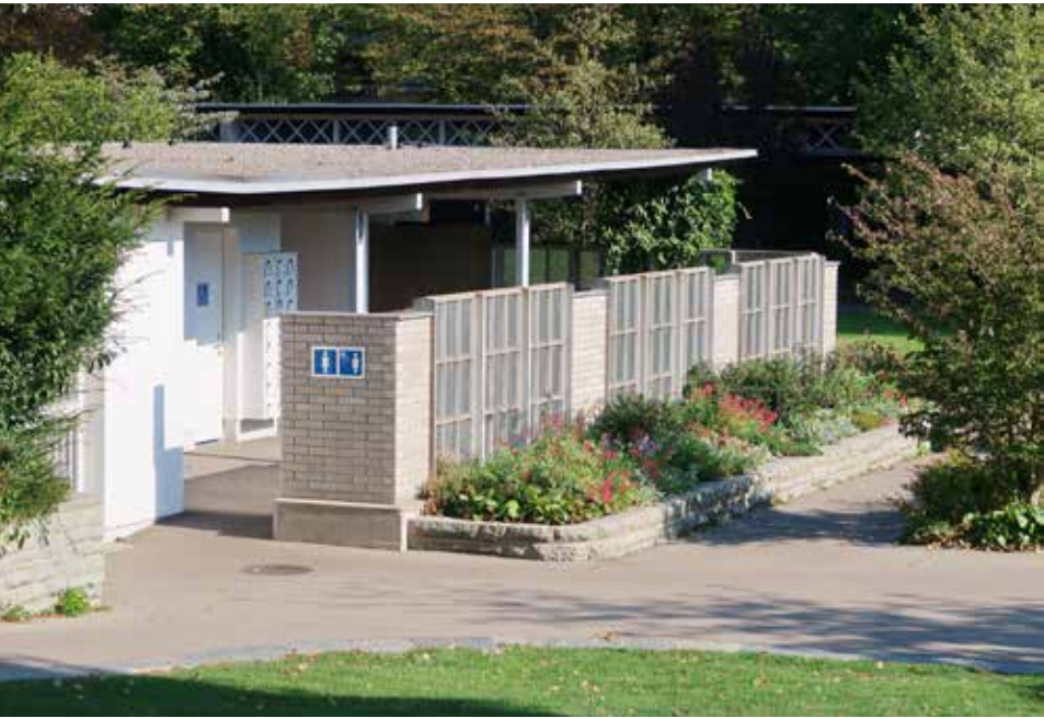
100 Schwimmbad Letzigraben: Paravents als Sichtschutz (Foto 2018)
