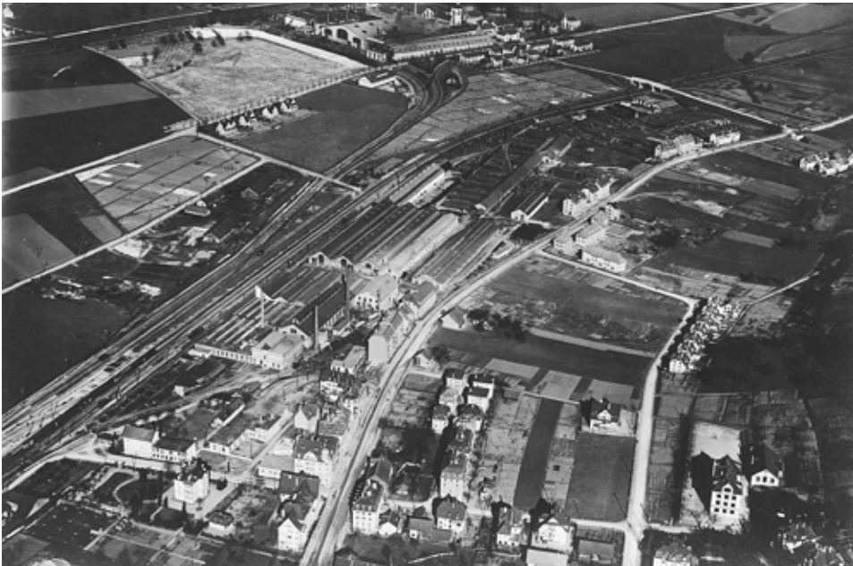
63 Die Wagonsfabrik in Schlieren wurde entlang der Eisenbahnlinie auf der grünen Wiese gebaut, die Zürcherstrasse läuft parallel zu den Bahngleisen. Links unten im Bild sind die Direktorenvilla und die Angestelltenwohnhäuser (mit Autoremise/Waschhaus) von Franz Bruno Frisch zu sehen. (Luftaufnahme von circa 1916)
