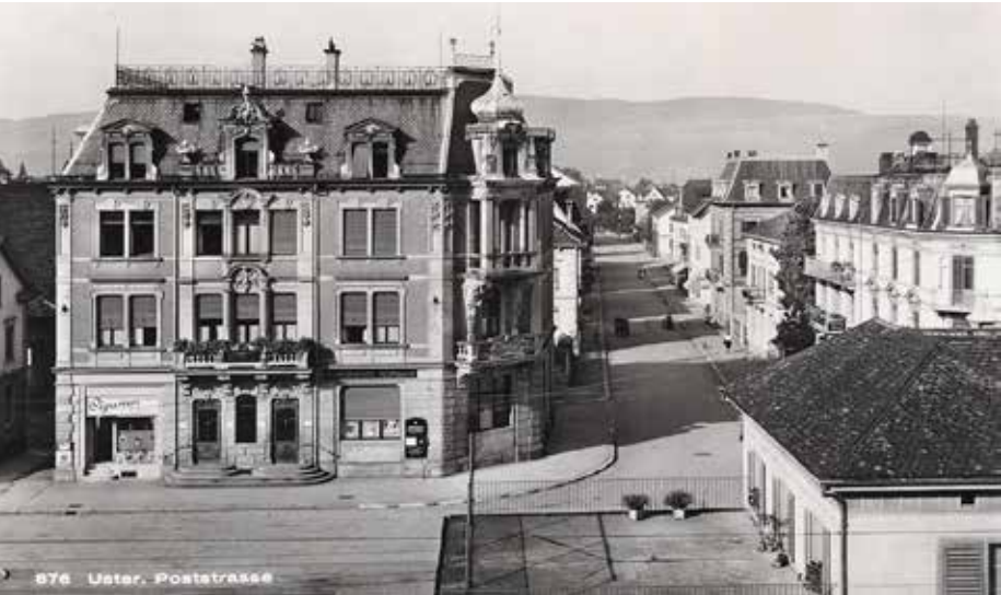
105 Emmanuel Walcher: Wohn- und Geschäftshaus gegenüber vom Bahnhof in Uster mit betonter Ecklösung (Foto von Herri Jakob Müller um 1925)
