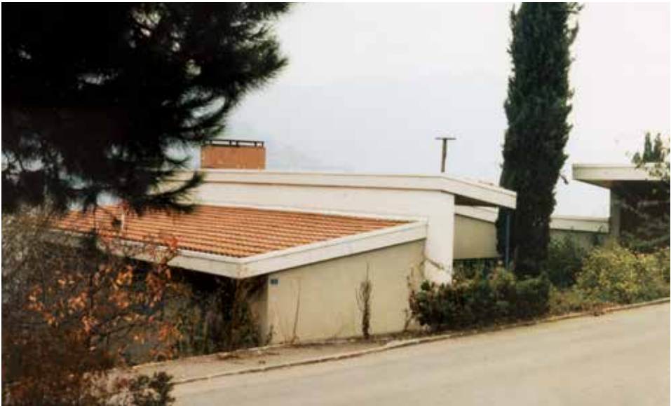
68 Straßenansicht des Hauses von Franz Frisch (Foto 1984)
