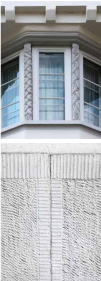
58, 59 Zurückhaltender Bauschmuck, gestockter und scharrierter Kunststein am Haus Scheitlin
